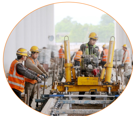
2026年5月3日,中铁十一局建设者在浙江省湖州市德清县杭德市域铁路舞阳车辆基地进行轨道组装起道作业。新华社发(谢尚国 摄)
