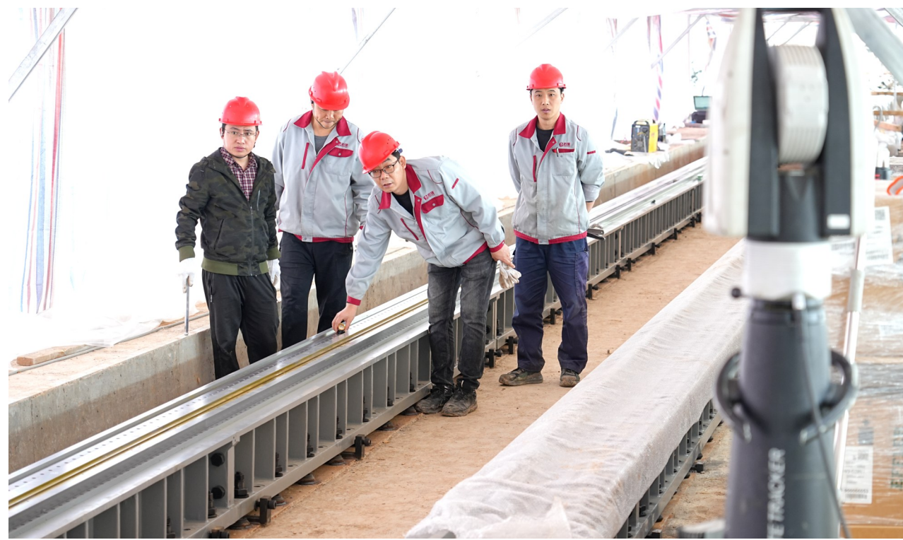
易龙航天项目现场,工作人员正在精调设备底座轨道。
