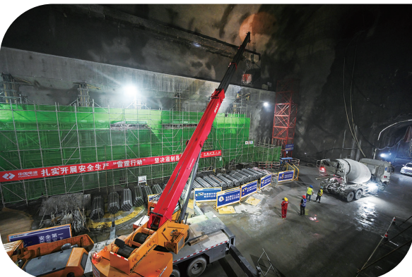
石台抽水蓄能电站地下厂房建设正酣
