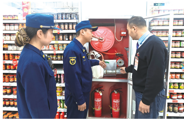
日前，贵池区消防救援大队深入辖区商场超市、沿街门面及高层住宅等重点场所，开展元旦节前消防安全检查，重点核查消防设施配备运行、疏散通道畅通等情况。图为检查现场。 记者 吴双甲 摄
