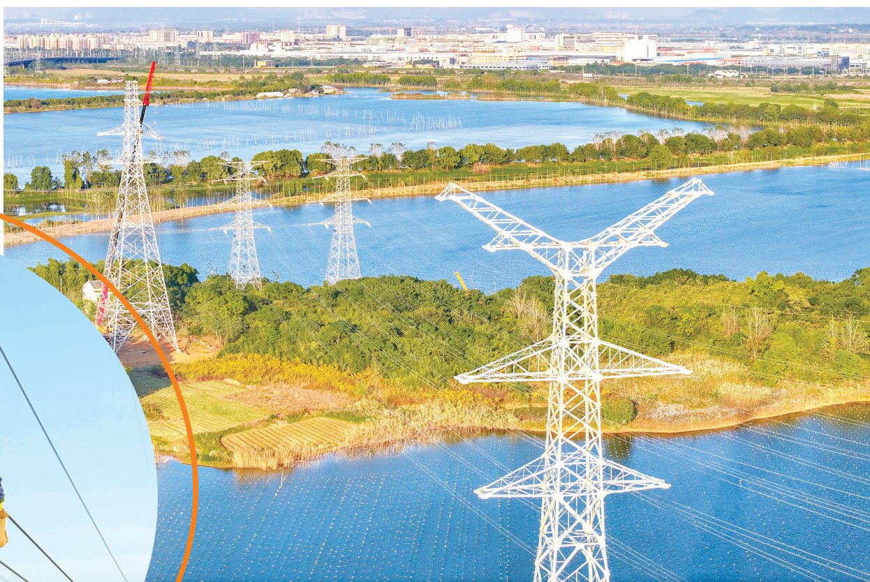
国能神皖池州发电有限公司九华发电厂二期220千伏送出线路工程新建标塔129基,新建线路长度47.4千米,预计年底全线贯通。目前,池州供电公司正在紧张有序地开展导线展放作业。 记者 李建军 通讯员 贾万田 摄
