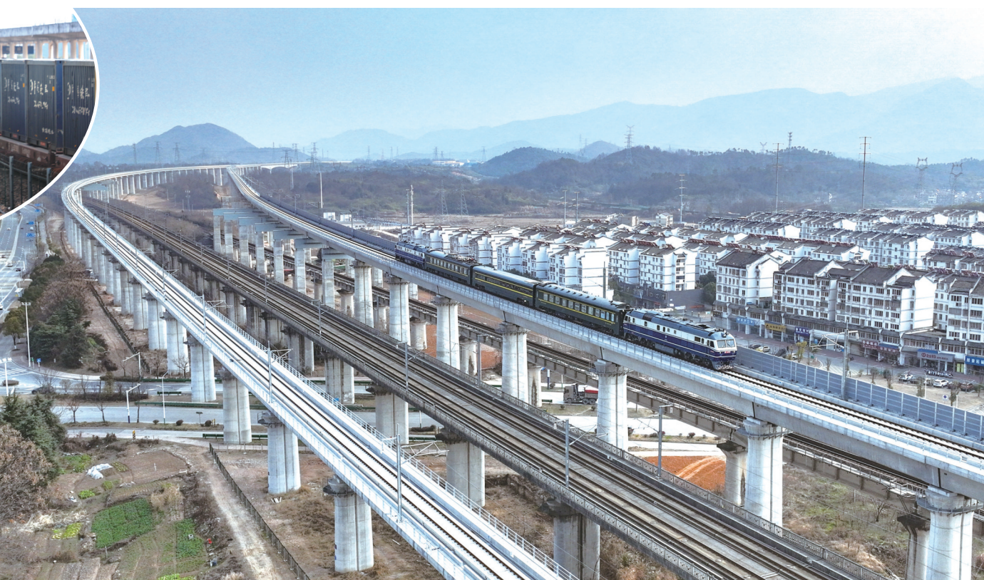
▲检测列车沿着池黄高铁驶向池州站。
